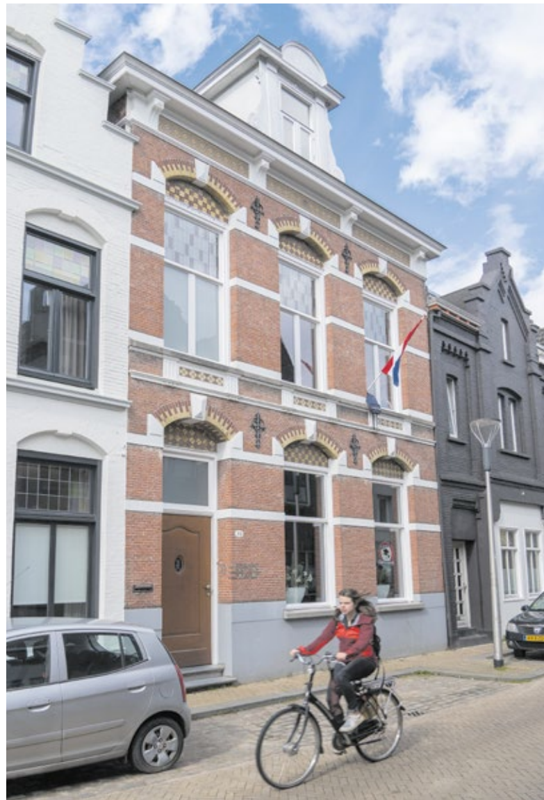
Poststraat 39 met klein formaat roodbruine bakstenen en fraaie detaillering.
