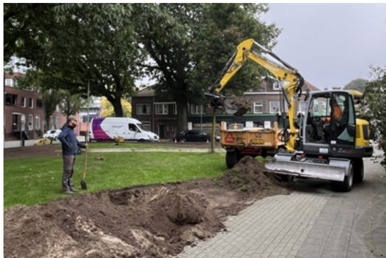
Graafwerkzaamheden aan het Watertorenplein.
